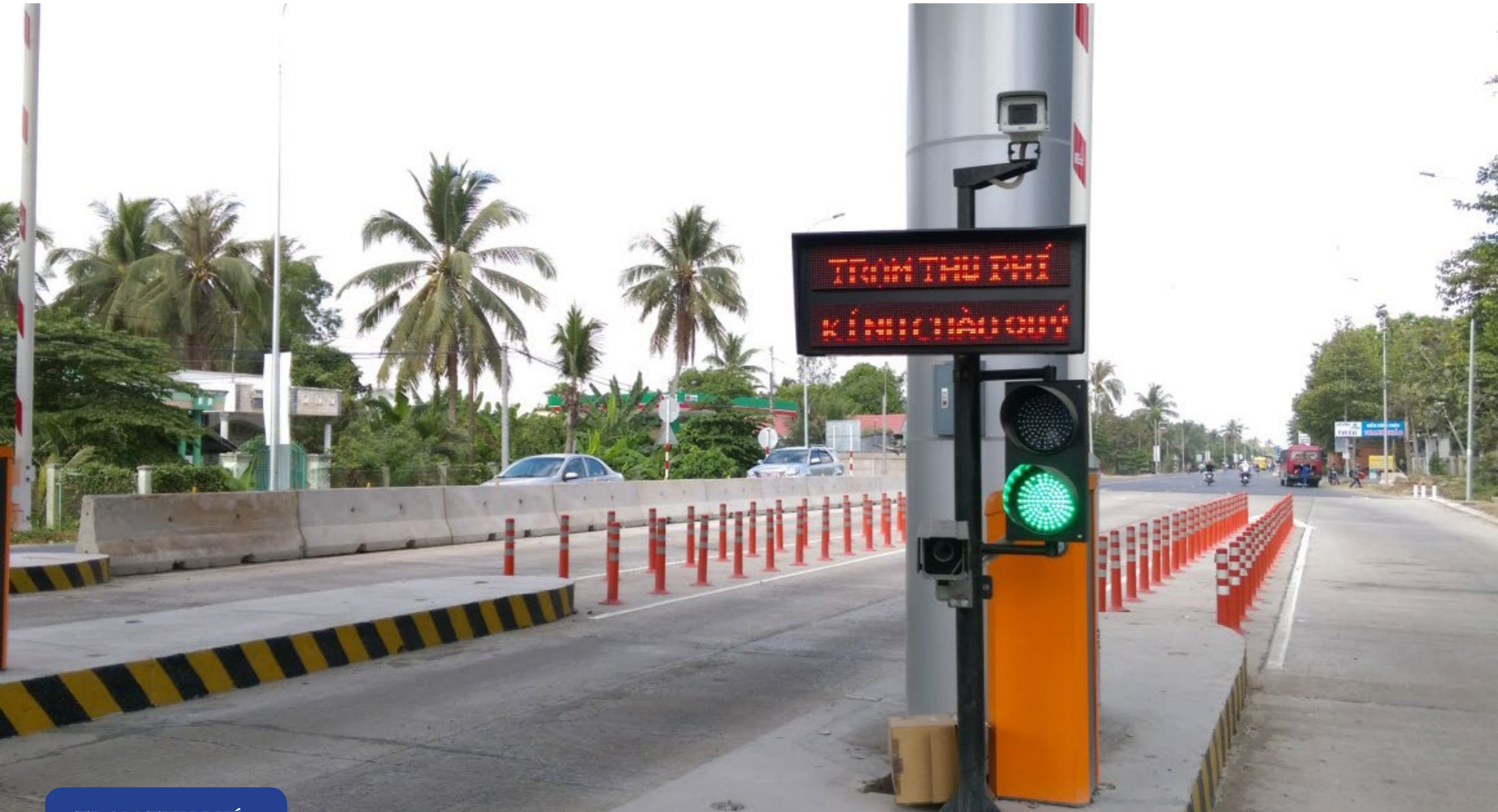
TRẠM THU PHÍ
